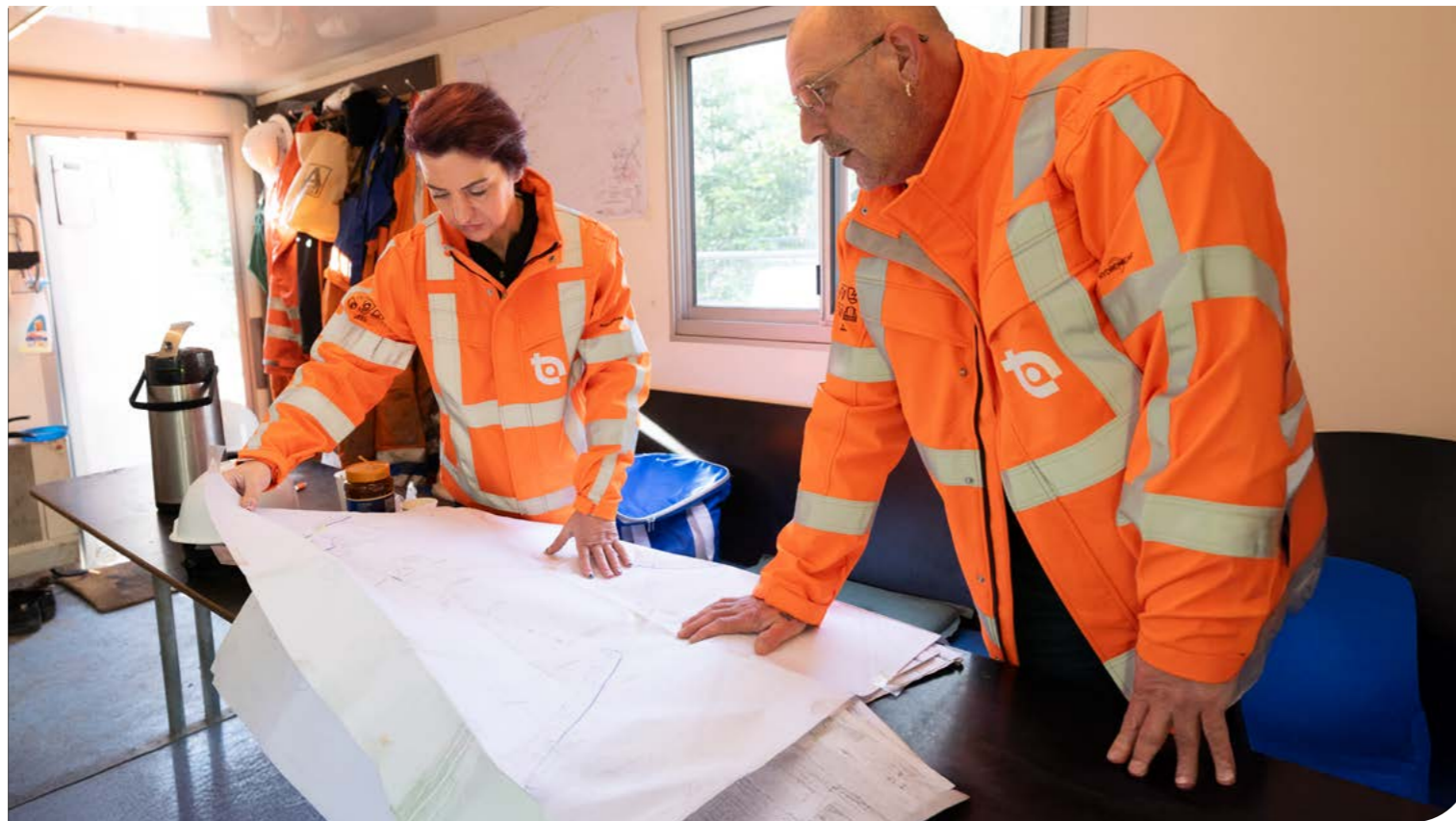
De energie- en watertransitie stelt hoge eisen aan de ondergrondse infrastructuur van Nederland.
